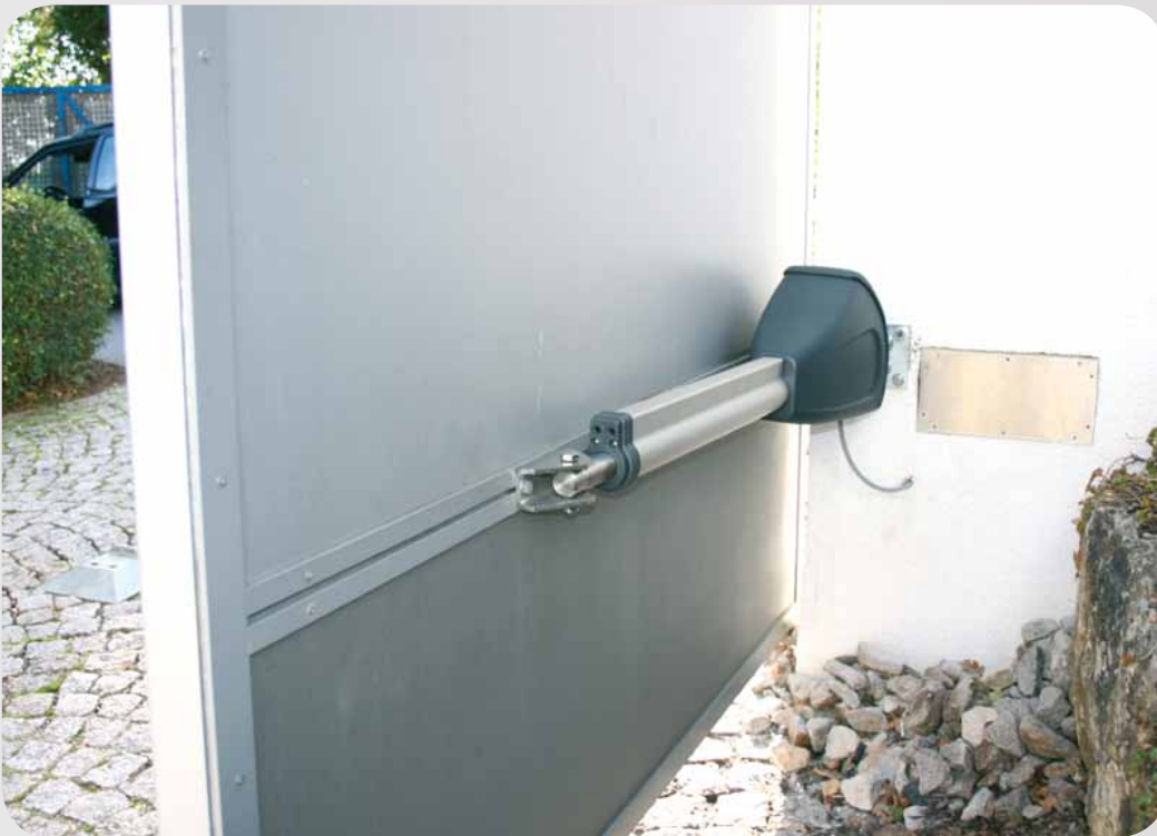
Einbaubeispiel des twist XL an einem geschlossenen Torflügel
